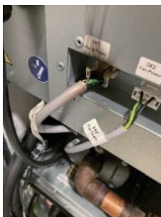
图7 电气接头在可靠性试验中的失效场景
